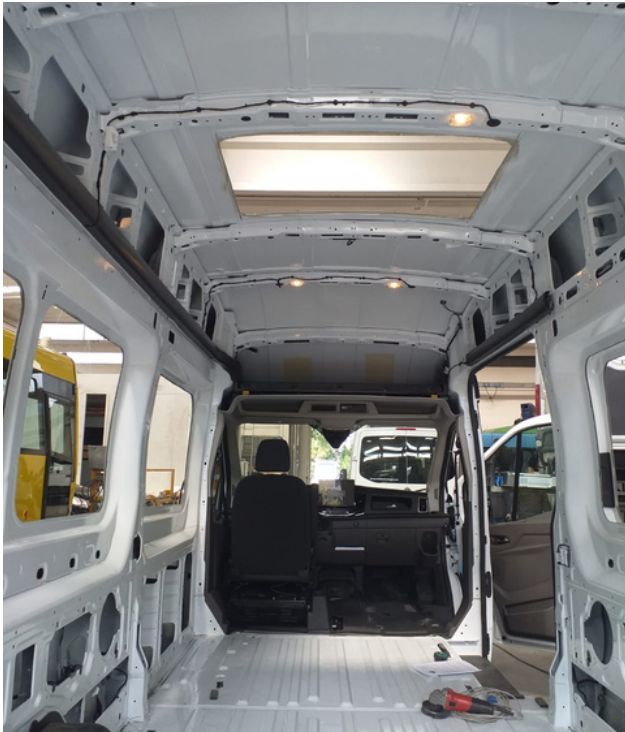
Lavorazione struttura portante
